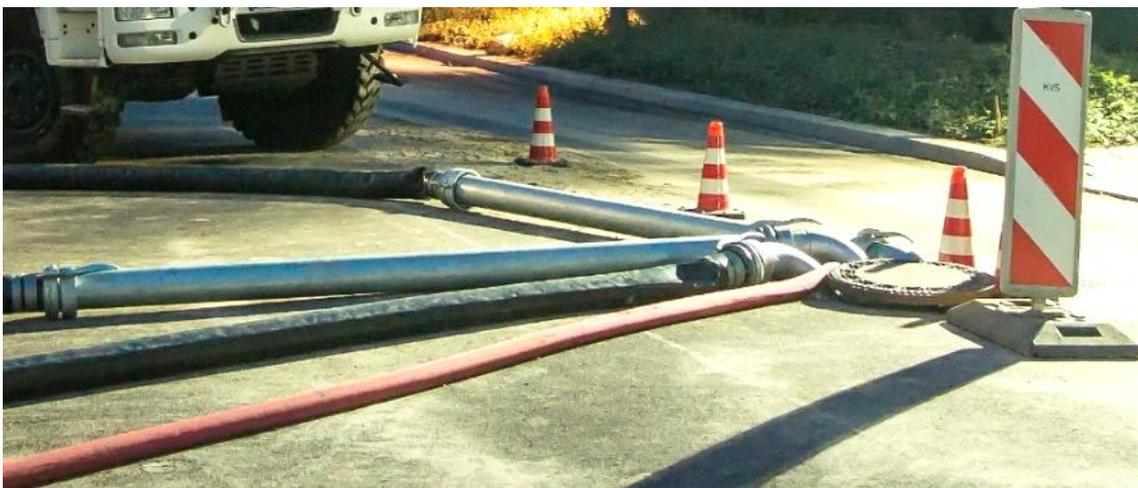
So wurde z. B. 2006 in **Magdeburg** mit drei F-150 mm-Leitungen und einer B-75 mm-Leitung über viele Stunden Schmutzwasser aus überfluteten Tiefräumen in einen DN-600-Straßenschacht eingeleitet.
