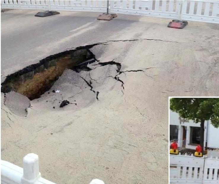
In der Folge kam es zur Zerstörung des Kanalbauwerks und zu Einbrüchen der Straßendecke aufgrund starker Auswaschung des Schacht- und Kanalbettes.
